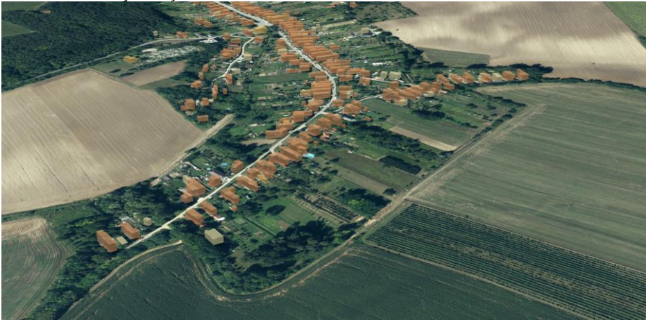
obr. 30 PFCelok Východný koniec
